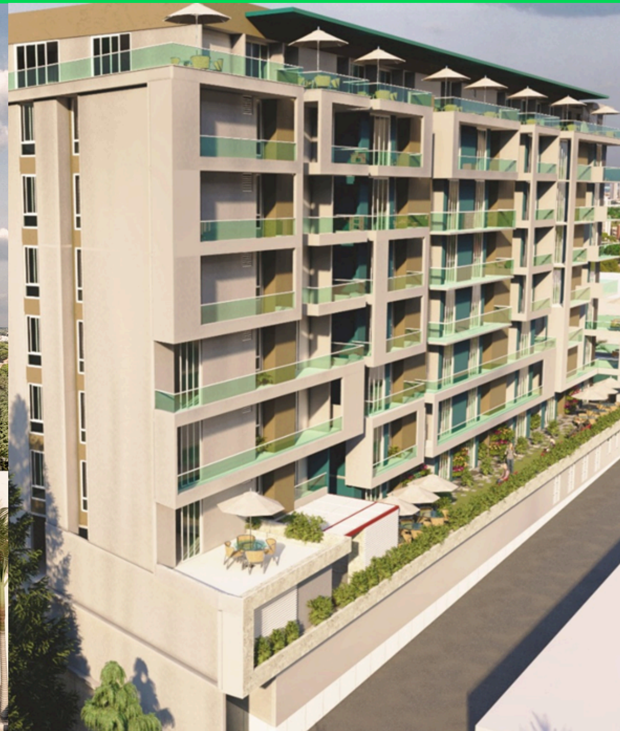
Lateral entrada sótano
